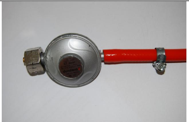
8. Verschieben Sie die Metallbinde auf den Stutzen des Druckminderers zurück und drehen Sie bis zum Anschlag zu. ACHTUNG! Bei sichtbaren Beschädigungen die Metallbinde austauschen.
